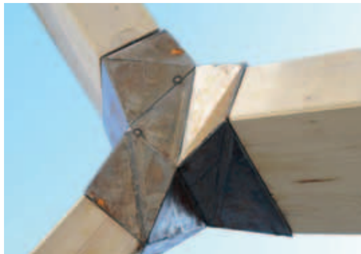
Bild 3: Detail: Parametrischer Knoten einer Voronoi-Wabe
