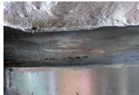
Abb.3: Bruchausgang mit Schleifspuren an der angrenzenden Oberfläche
