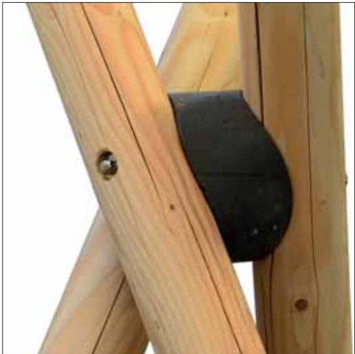
Abb. 7: Innenknoten in Rundstützenkonstruktion
