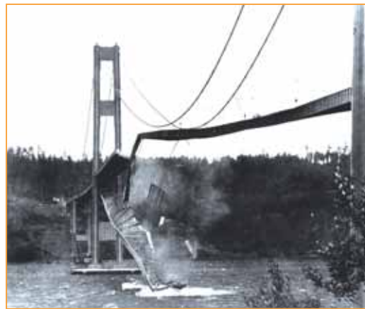
Abbildung 1: Einsturz der Tacoma Narrows Brücke (Encyclopedia Britannica)
