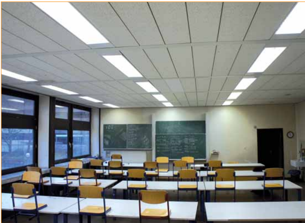
Raumbeleuchtung mit Leuchtstoffröhren vollständig eingeschaltet.
