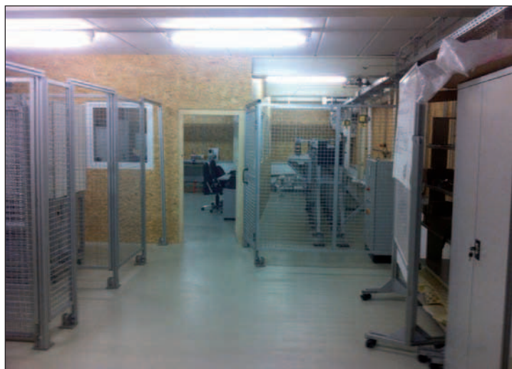
Abb. 3: Das Kabellabor mit Testzellen
