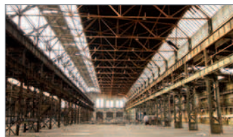
Abb. 2 und 3: Lokrichhalle, Bestand 2013
